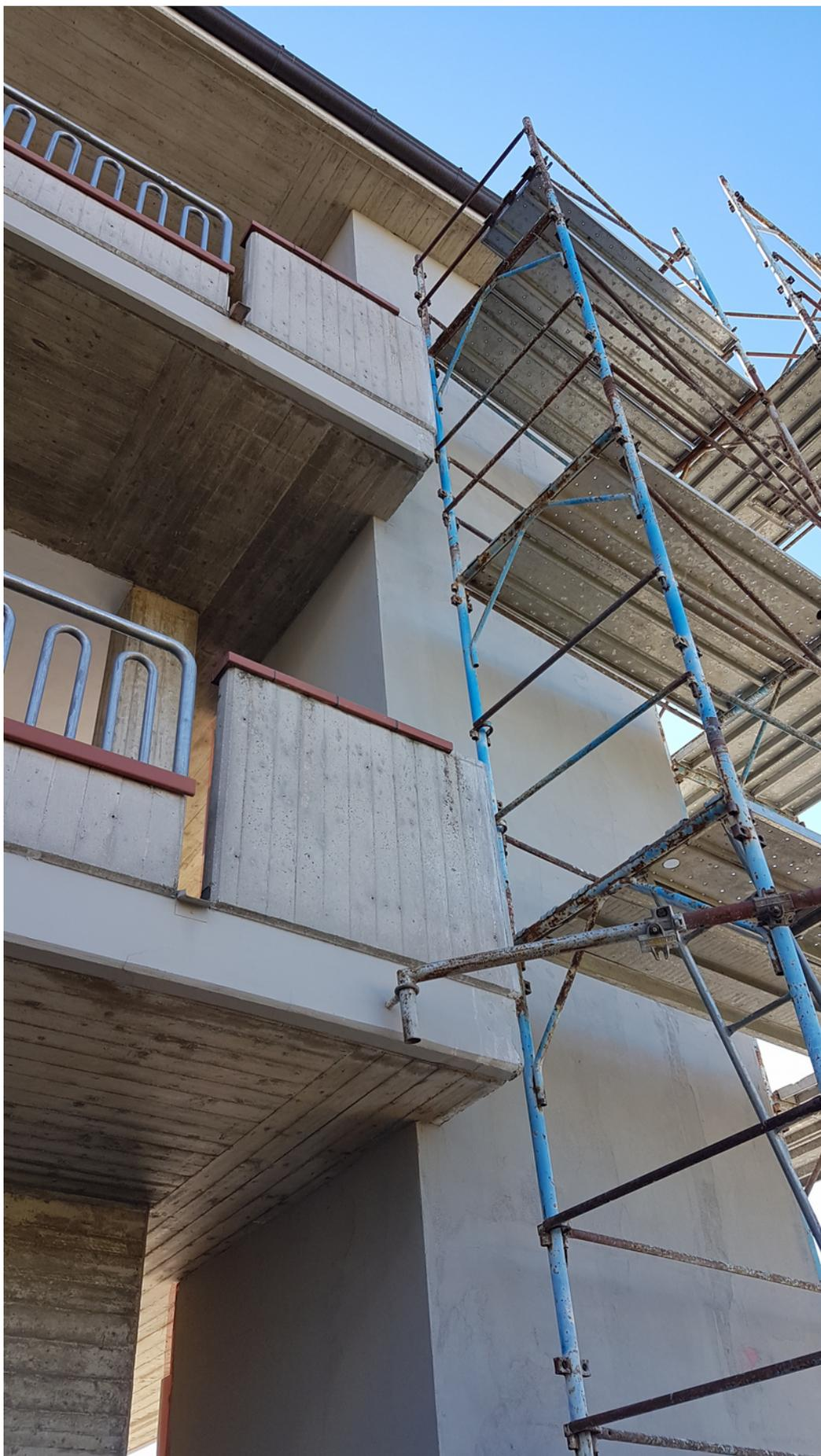
*incastellatura metallica esterna con tamponatura in Aquapanel Outdoor: successiva rasatura, intonacatura e pittura seguendo l'estetica delle pareti contigue dell'edificio*
