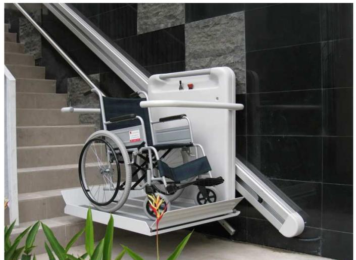
Si tratta di pedane, sedili, piattaforme reclinabili e non, con comandi a bordo che scorrono su una guida inclinata lungo una o più rampe di scale. Non si muovono perciò in un vano proprio, a differenza delle piattaforme elevatrici per. Come le piattaforme, sono soggette alla Direttiva Macchine 2006/42/CE, ma non richiedono disabli un collaudo di singolo impianto e non sono obbligatorie manutenzione periodica e verifiche biennali di organismi notificati.
